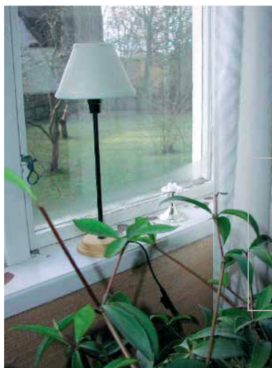
Figur 1. Hvis der er mere end et par centimeters fugt på termoruden om morgenen i soveværelset, så bør det give anledning til en nærmere undersøgelse af ventilationsforholdene.
